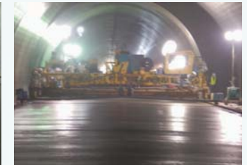
北海道横断自動車道白糠町 底路トンネル舗装工事
