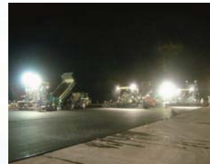
中標津空港整備事業滑走路改良工事
