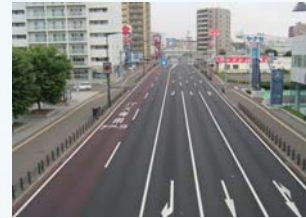
一般国道36号札幌市月寒 舗装修繕外一連工事
