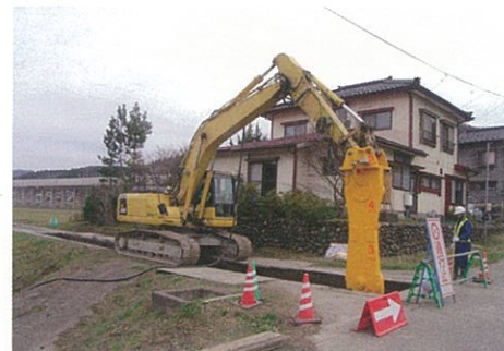
民家の近接部における改良施工
