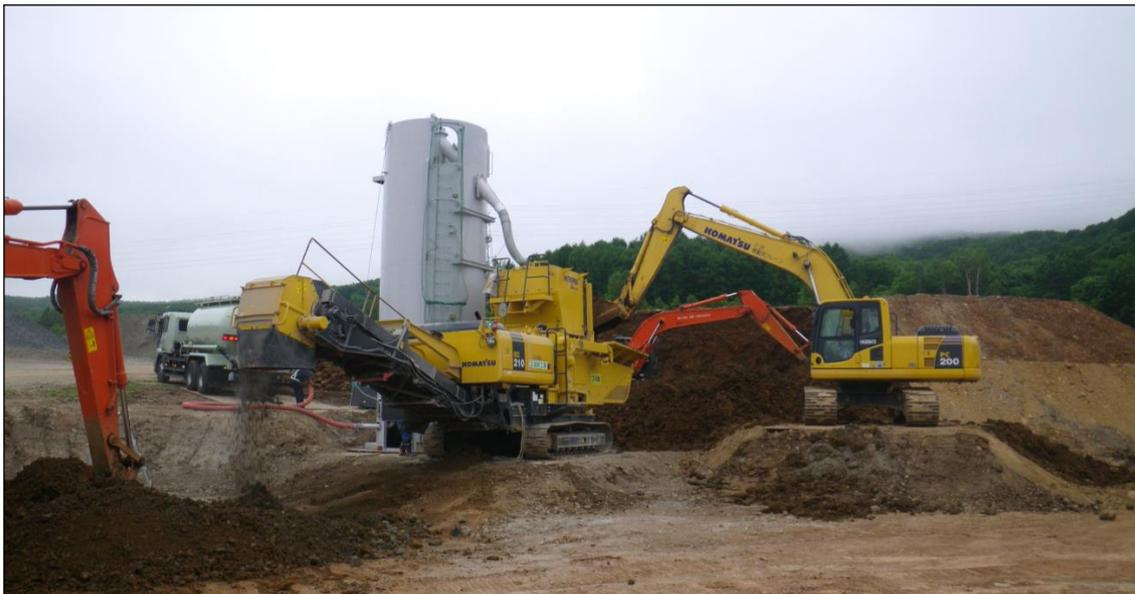
移動式土質改良機（リテラ）＋バックホウ（土砂投入）
