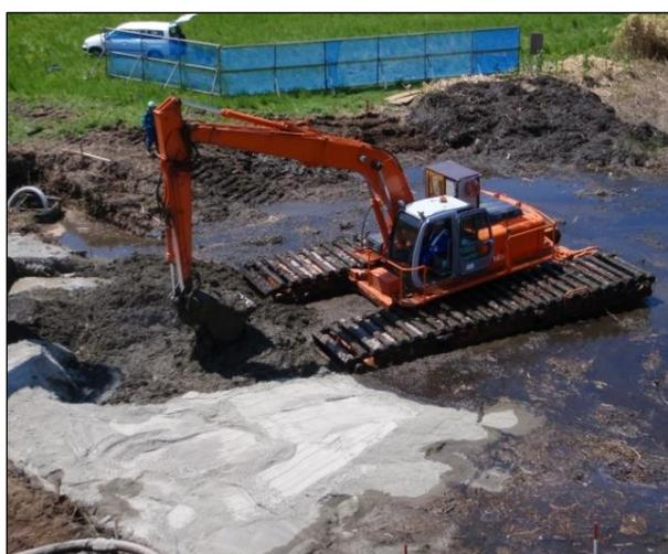
泥上車+バケット式スタビライザーによる混合・攪拌
