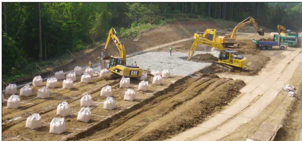
バケット式スタビライザー施工状況（散布・混合）
