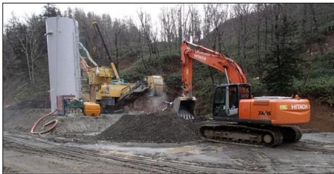
自走式土質改良機による混合・攪拌
